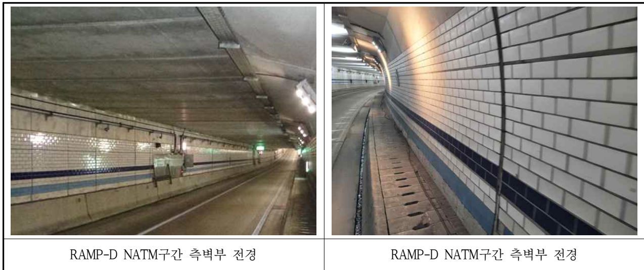
【사진 3.3.25】 NATM구간 측벽부 전경
