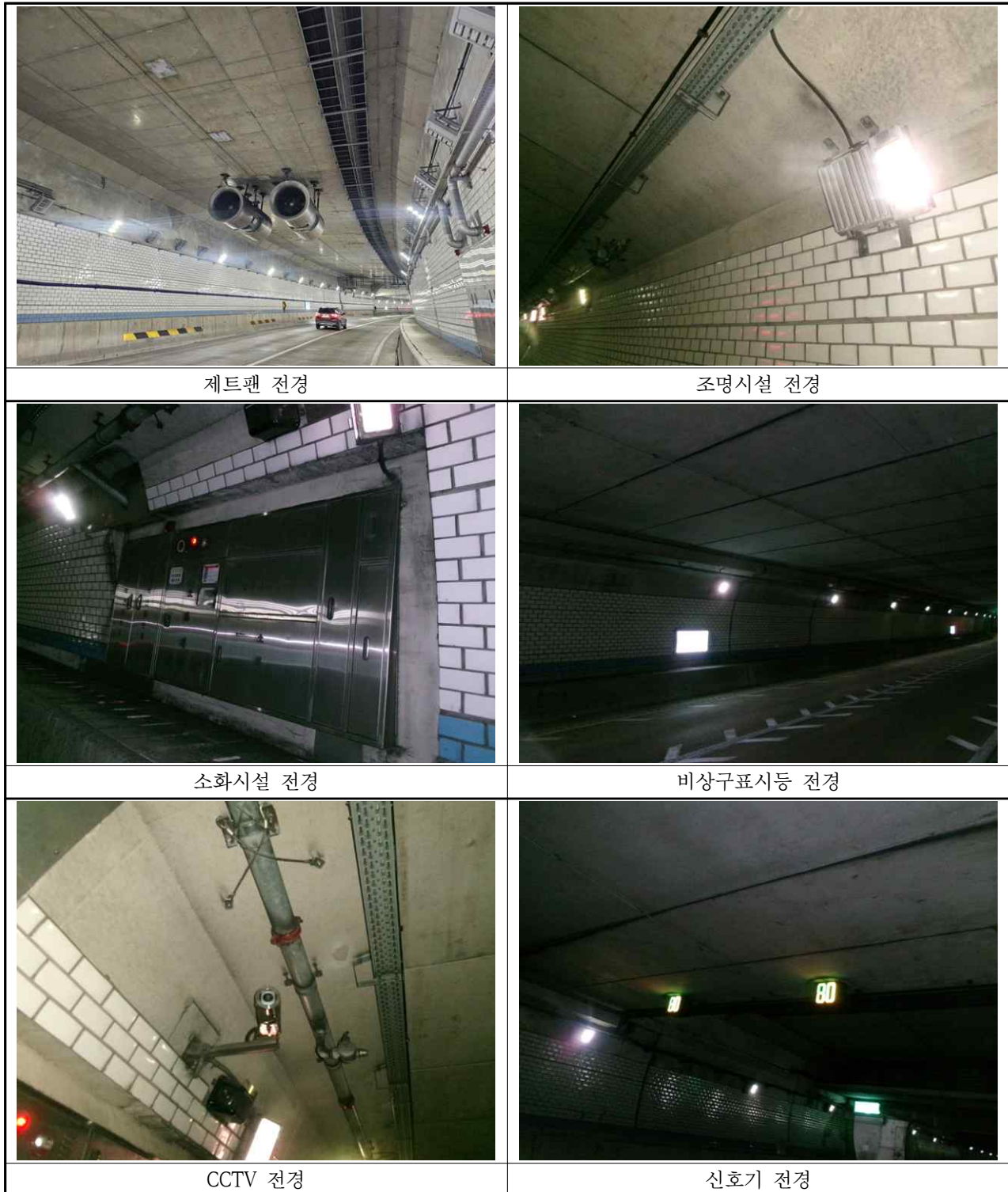
【사진 3.3.43】 부속시설 전경
