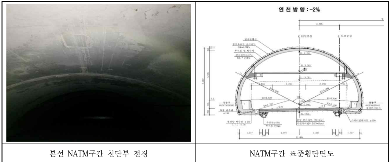
【사진 3.3.5】 NATM구간 천단부 전경
