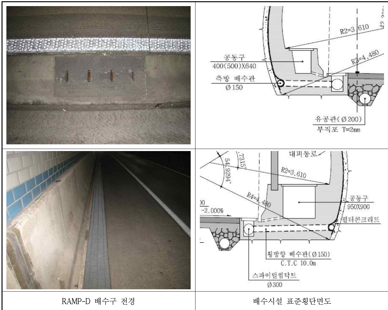
【사진 3.3.33】 배수시설 전경
