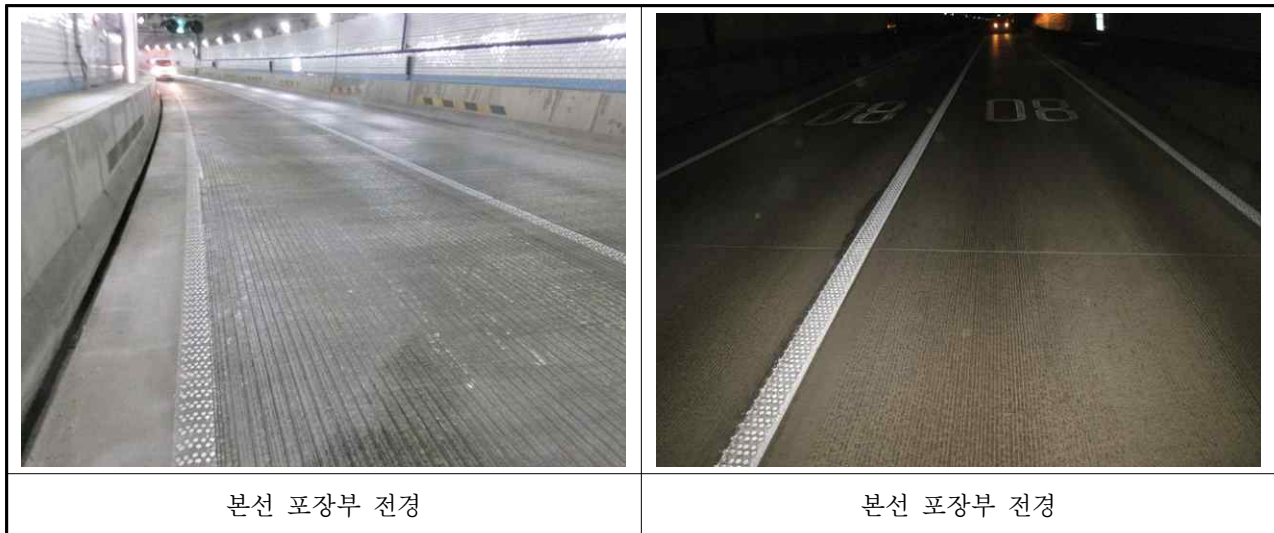
【사진 3.3.11】 포장부 전경
