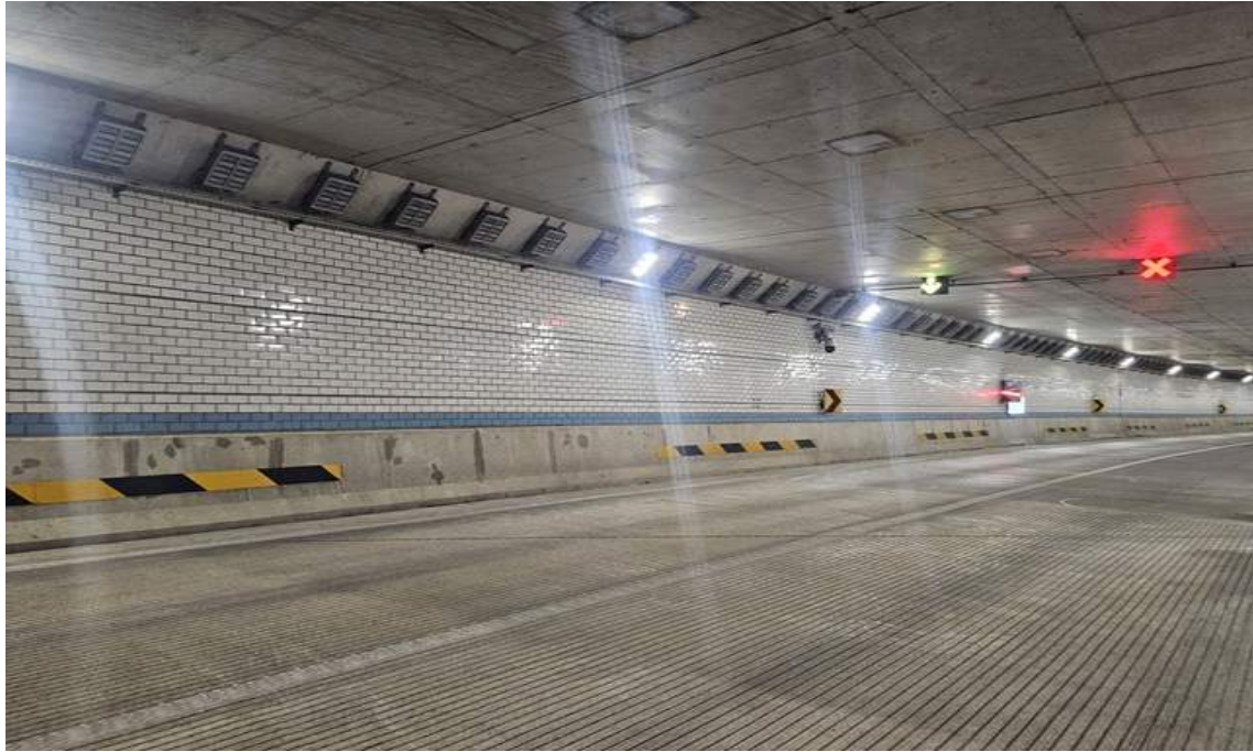
BOX구간 벽체 전경
