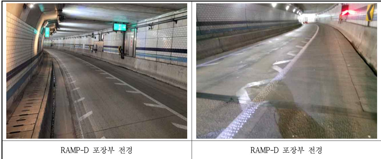
【사진 3.3.29】 포장부 전경
