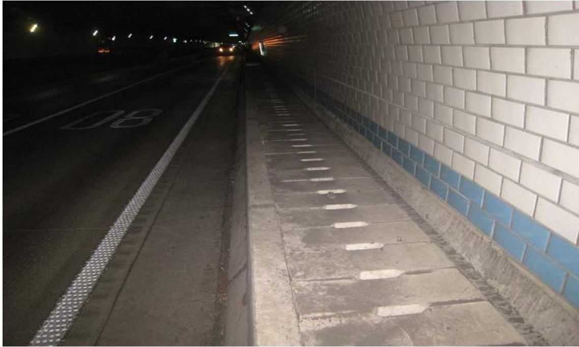
NATM구간 공동구 전경
