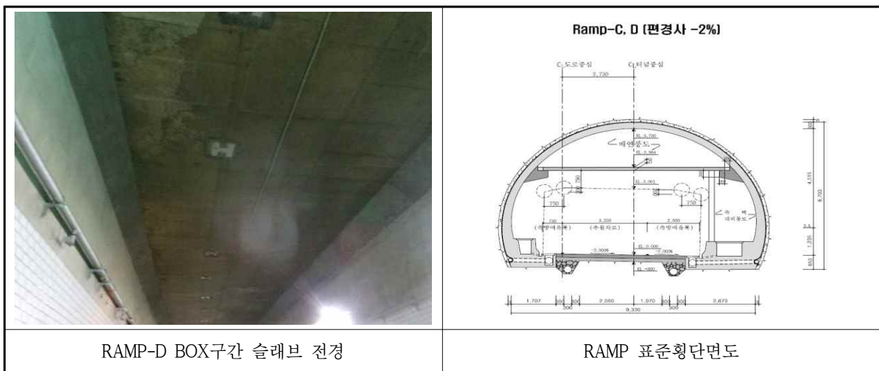
【사진 3.3.19】 BOX구간 슬래브 전경
