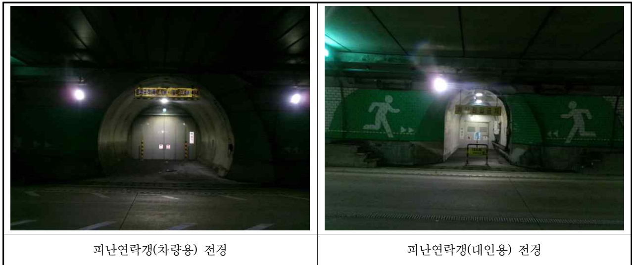
【사진 3.3.37】 피난연락갱 전경
